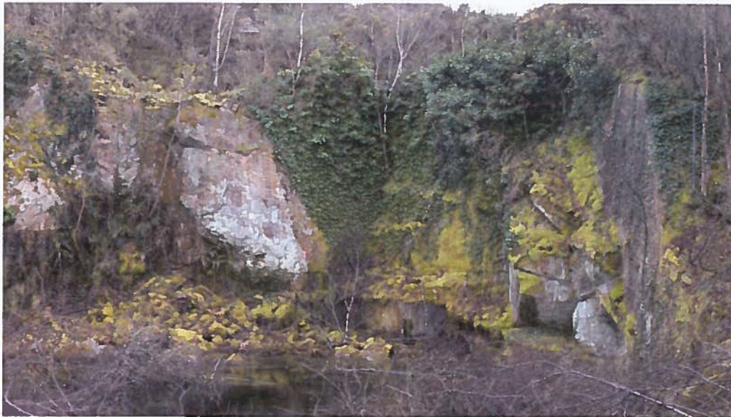
Aspect général de l'excavation et du front de taille
